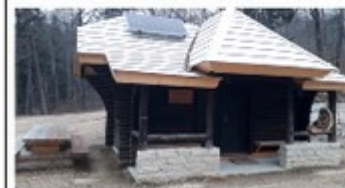
Das Dach wurde erneuert und mit einem Solarpanel versehen.
