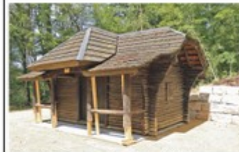
Die Langenbodenhütte an ihrem neuen Standort
